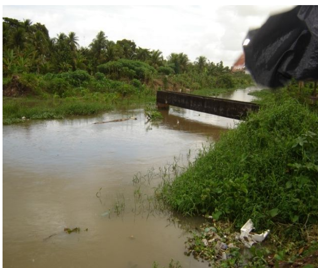
Foto 01. Foto do rio Preto, que atravessa a cidade. Do lado direito podemos notar o lixo e esgoto que o assoreia, causando mau cheiro e enchentes nos meses de inverno. Fonte: Fábio Mello e Thiago Burburema. Agosto de 2007
