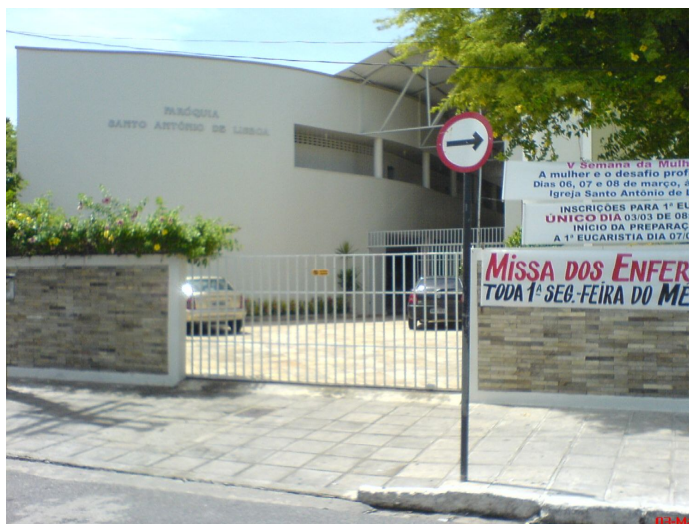
Foto 1. Vista externa da frente da Paróquia Santo Antônio de Lisboa.
