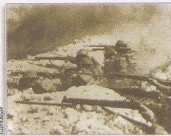
Trincheiras empregadas nas frentes europeias.
