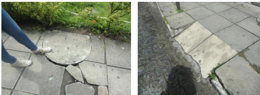
**Figura 2 e 3, respectivamente: Falta de manutenção na calçad; e rampa excutada em desconformidade com a NBR 9050 (ABNT, 2004).**
